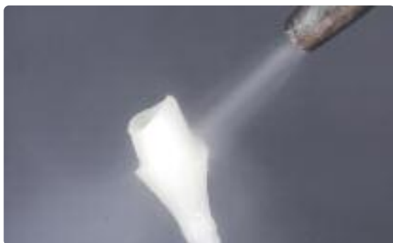
Nettoyer le pilier sous un jet de vapeur avant l'application du ZirLiner
